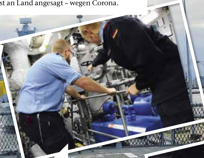
Ich bin in die Ausbildung eingebunden, hier erkläre ich einem Kameraden technische Details zur Abortvakuumanlage für die Toiletten an Bord
